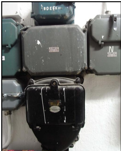
Elsystemet i källaren hade under åren utökats, lappats och lagats, men var trots detta helt underdimensionerat. Till vänster den gamla huvudsäkring, till höger den nya anläggningen.
