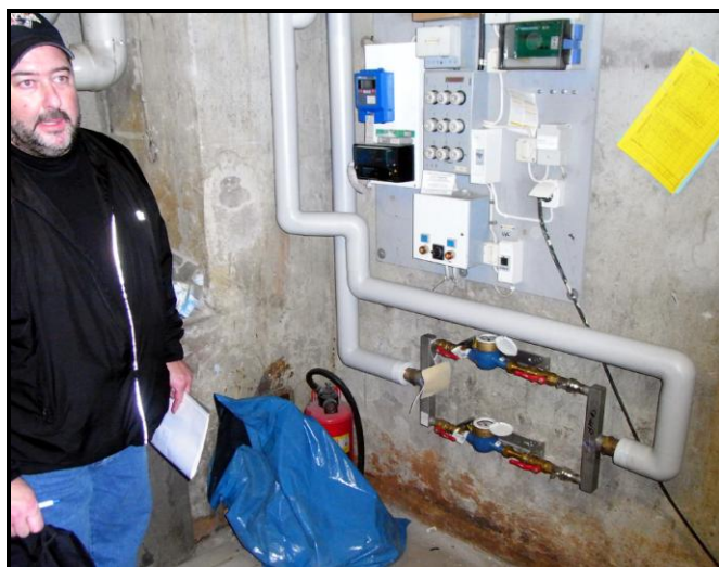
Vår energikonsult beundrar den nya kallvattenledningen in till huset med mätare och isolering. Värmecentralen har sedan fått en uppsnygning.
