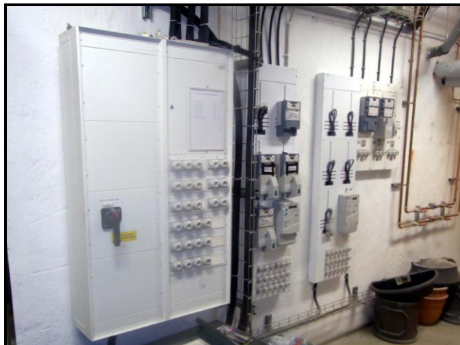
Elsystemet i källaren hade under åren utökats, lappats och lagats, men var trots detta helt underdimensionerat. Till vänster den gamla huvudsäkring, till höger den nya anläggningen.
